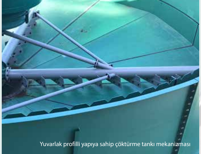
Vietnam'daki 60 m cıvata bağlantılı çöktürme tankı
